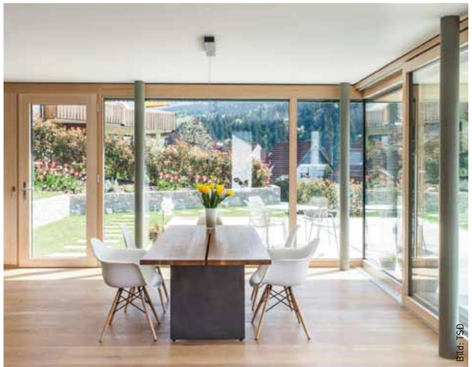
Die Neufassung der DIN 18008 sieht vor, dass bei jeder zugänglichen bodentiefen Verglasung Sicherheitsglas eingesetzt wird.
